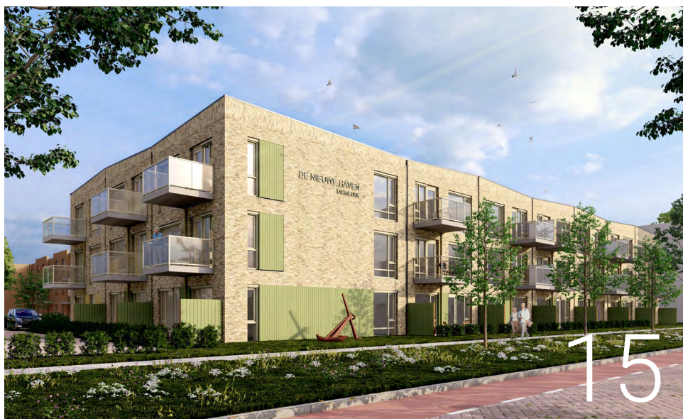
Start bouw van nieuwe woonlocatie De Nieuwe Haven
